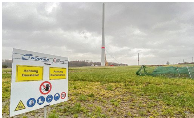
Auf der Windradbaustelle gegenüber vom Dattelner Kraftwerk wird jetzt der Endspurt eingeläutet. Wenn das Wetter mitspielt, sollen bis Ende der nächsten Woche die Windanlagen fertig montiert sein. FOTO SEBASTIAN BALINT
