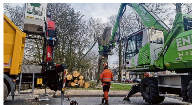
Die Firma Baumdienst Engbers Castrop GmbH kündigte die Arbeiten an der Genthiner Straße für Montag (5.2.) an. FOTO KÜBART
